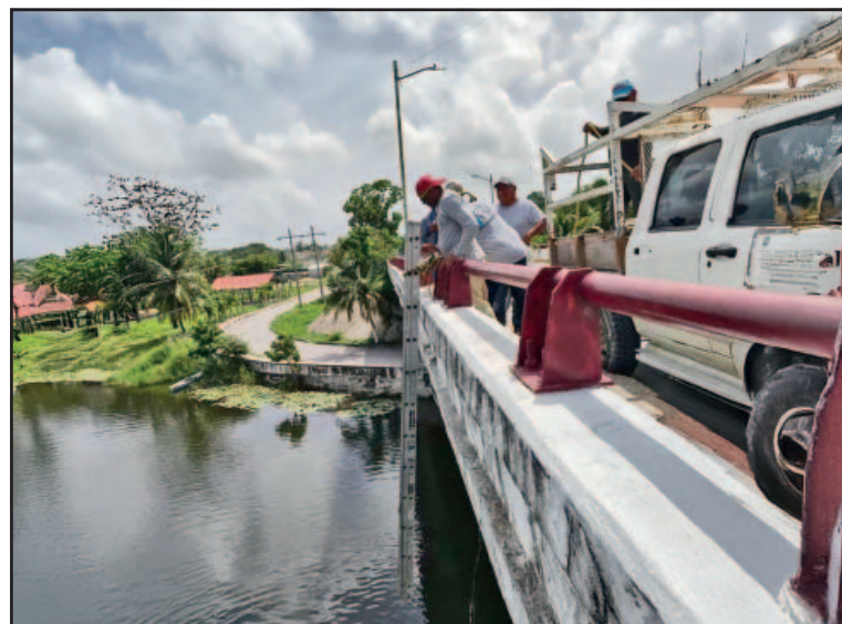
Los trabajos se centraron en el tramo sobre el puente. (POR ESTO!)
