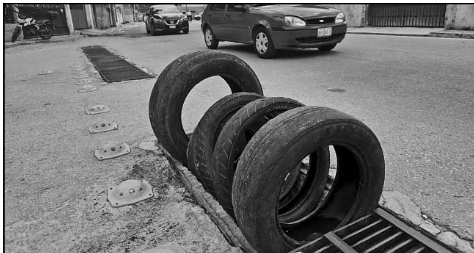
Los habitantes colocaron llantas alrededor de la alcantarilla para evitar accidentes.
