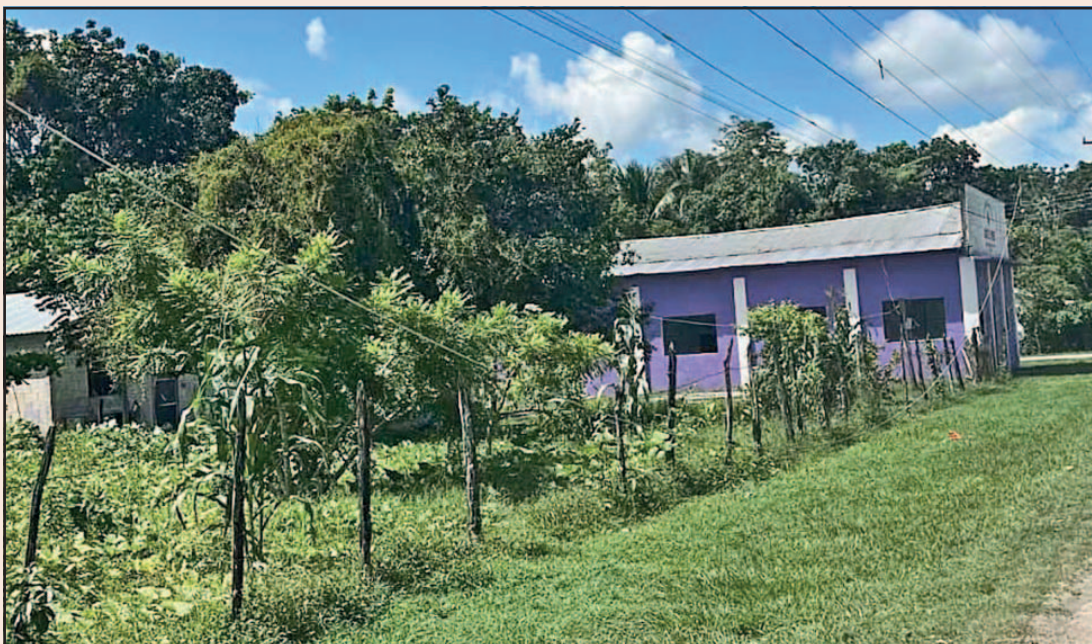
Algunas partes no tienen electricidad desde el jueves debido a supuestos cables caídos. (POR ESTO!)
