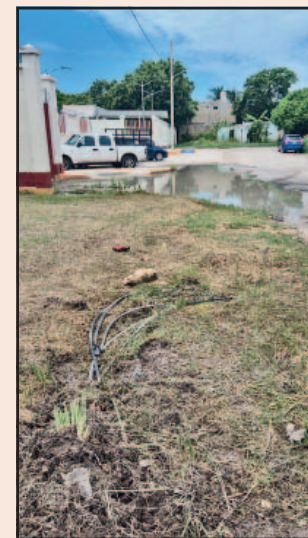
Piden que las tuberías sean enterradas. (Jorge M.)
