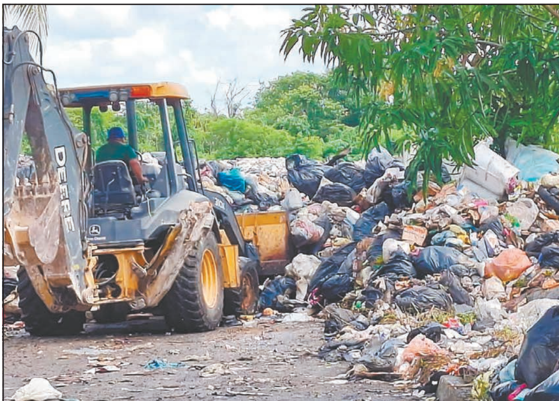
Debido a la falta de equipo adecuado se tienen dificultades para compactar y acomodar los residuos.
