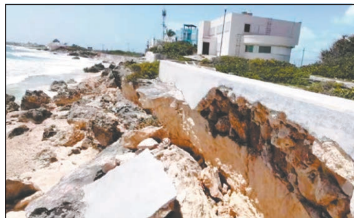
La exposición de las varillas acelera su degradación. (Ovidio López)
