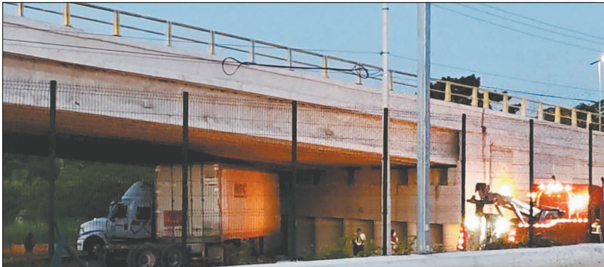
El conductor del vehículo pesado golpeó en varias ocasiones la estructura al tratar de zafarse; ocasionó que la parte de atrás se doblara y sufriera daños considerables. (F. Baeza)
