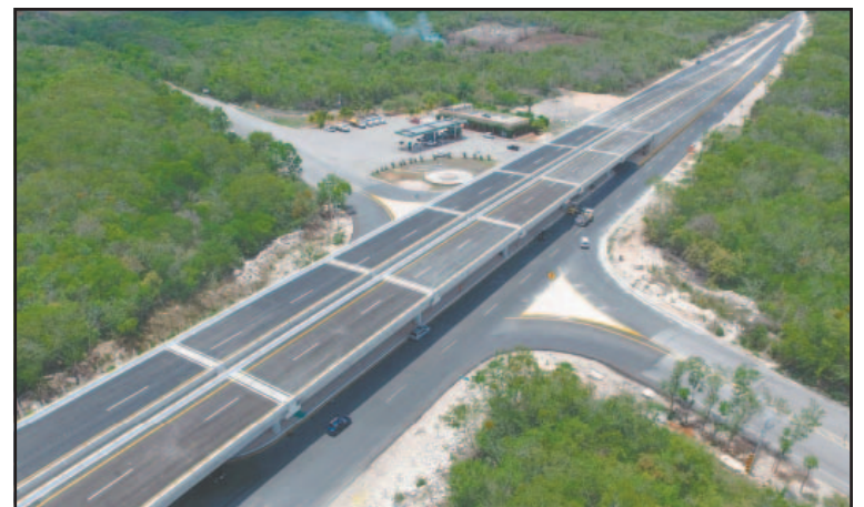
Las acciones buscan disminuir riesgos derivados de inundaciones.
