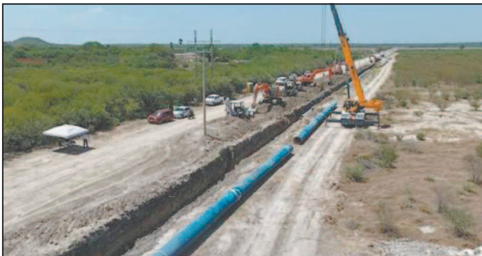
El Acuaférico fue reconocido como obra prioritaria para la administración federal.
