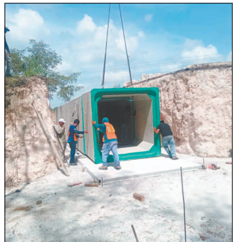
Ejidatarios dijeron que vigilarán la conclusión de la obra. (F. Olvera)
