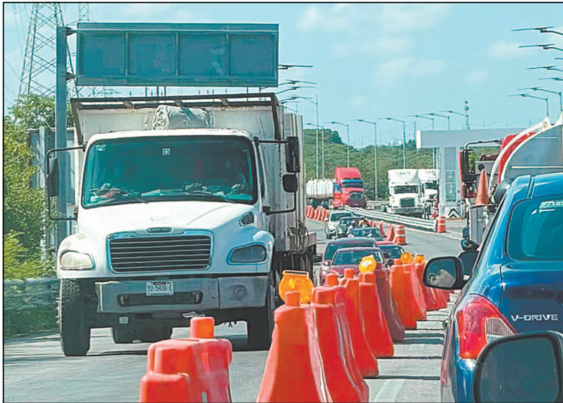
Las labores tendrán una duración aproximada de dos meses, por lo que exhortan a tomar precauciones.
