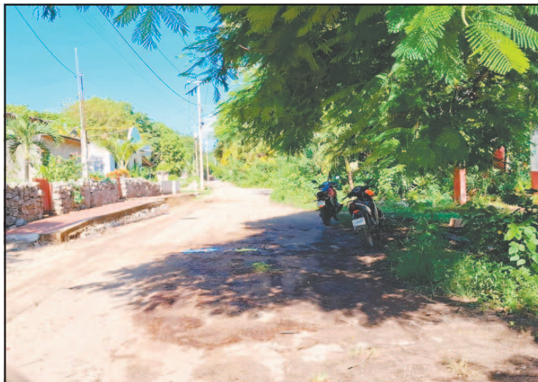
La falta de luminarias representa un riesgo para ciudadanos. (E. Cauich)
