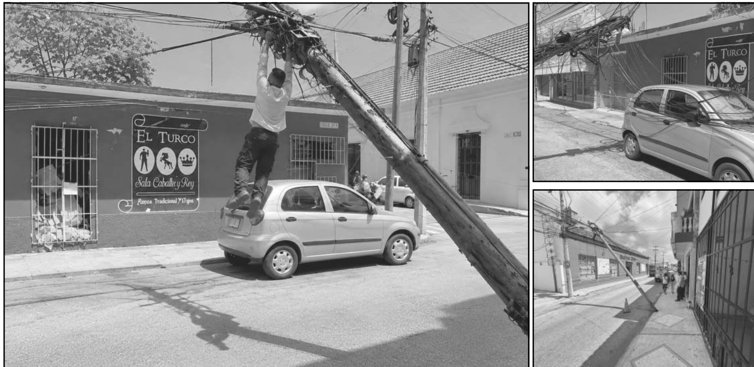
El empleado logró descender con ayuda de ciudadanos y otro trabajador; los tensores evitaron que las estructuras terminaran sobre el pavimento.
