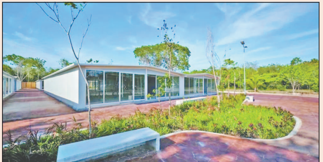
El proyecto permanece sin atraer inversiones ni impulsar actividades económicas locales. (POR ESTO!)
