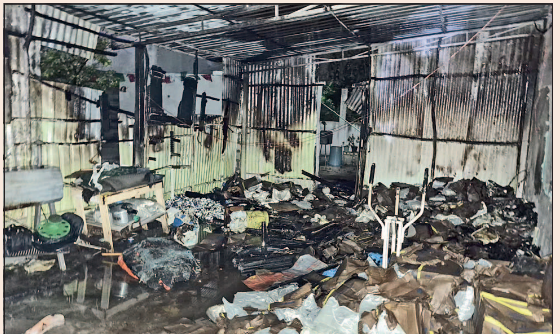
Nada de lo que se encontraba en el interior pudo salvarse de las voraces llamas. (Israel Lozano)
