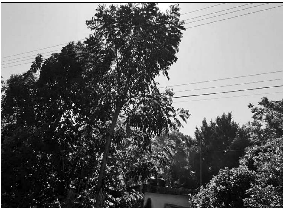
Con el viento, las ramas pegan con los conductores eléctricos hasta que sacan chispas.
