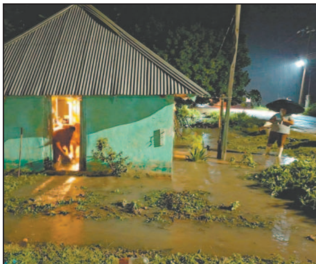
POR segunda ocasión en el año, pobladores de una comunidad terminan inundados por la carencia de un sistema de drenaje eficiente.- (POR ESTO!)
