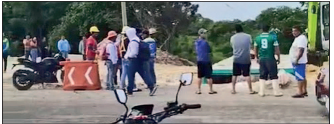
Se requirió del uso de maquinaria para quitar del material que obstruía algunas alcantarillas. (POR ESTO!)
