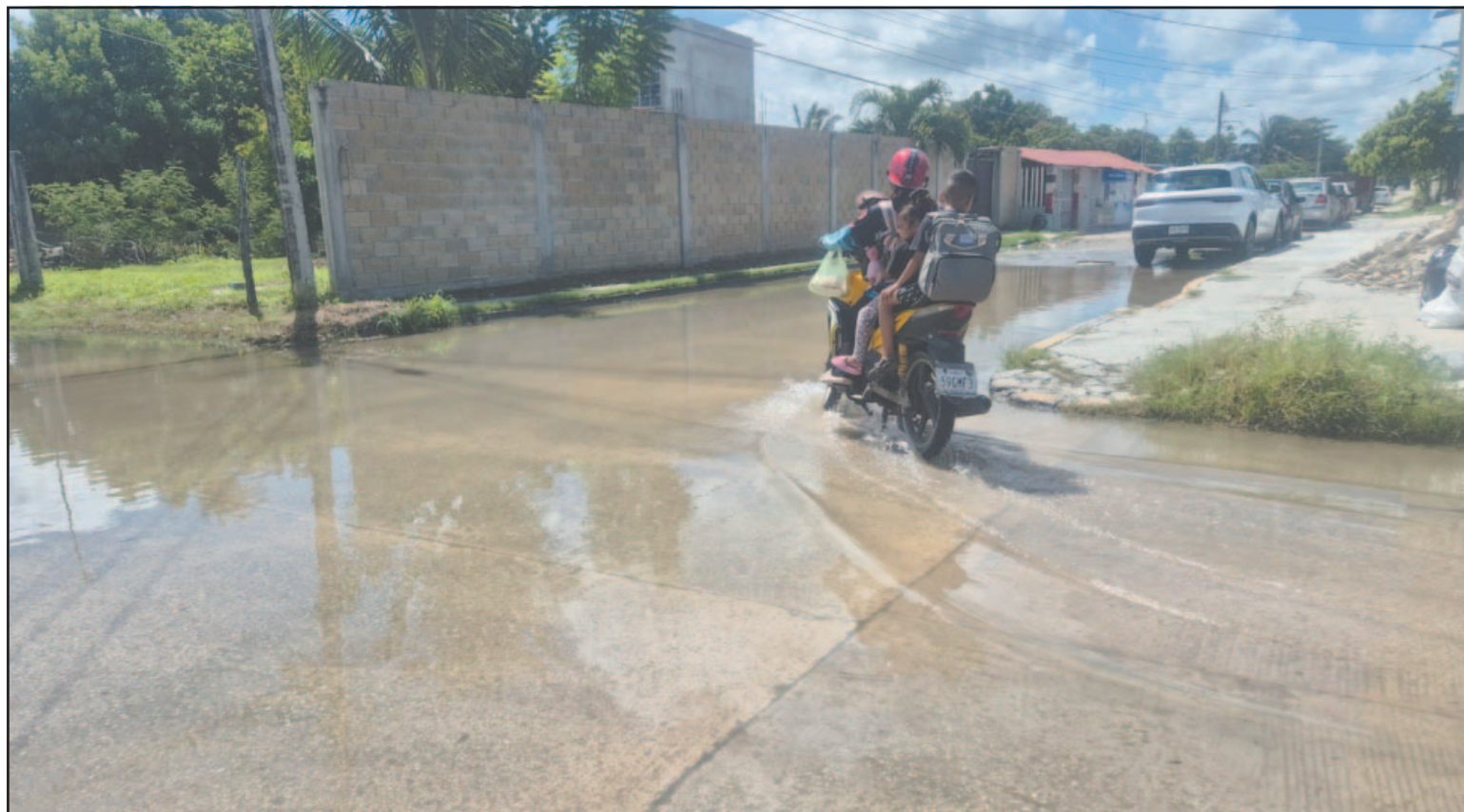
El líquido entra a los hogares con el paso de los vehículos ante la falta de desazolve de los pozos de absorción desde hace casi 10 años.
