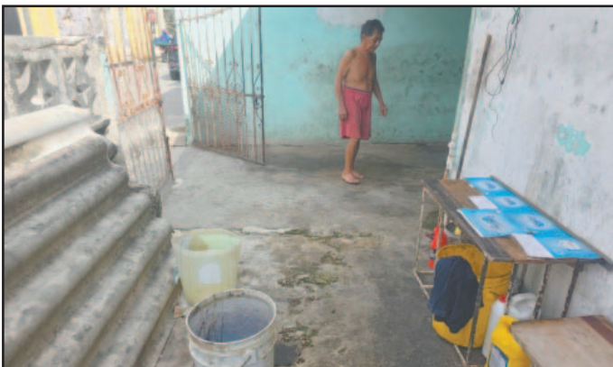
HABITANTES del barrio más grande de la capital padecen por una probable obstrucción en las tuberías de la red hídrica. Exigen solución.- (POR ESTO!)
