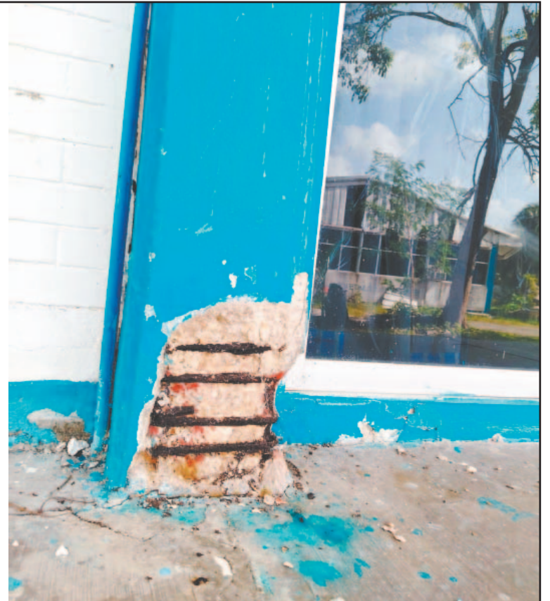
El último mantenimiento fue hace ocho años. La pintura y estructuras expuestas al salitre tienen daños considerables. (Fernando Olvera)
