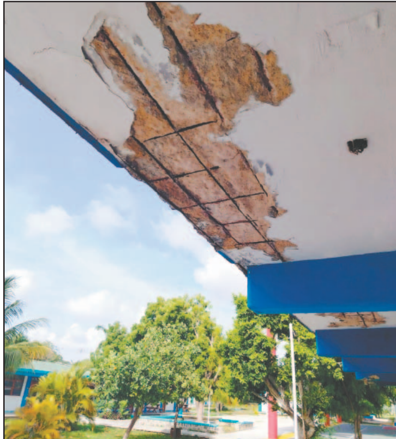
El último mantenimiento fue hace ocho años. La pintura y estructuras expuestas al salitre tienen daños considerables. (Fernando Olvera)
