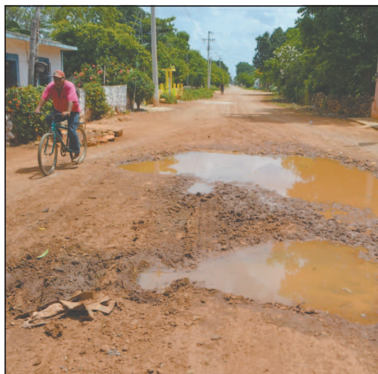
Les repararán cinco tramos de calles en lugar de tres. (Mauriel Koh)
