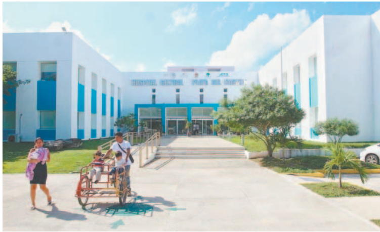
La falta de medicamentos es uno de los reclamos en Playa del Carmen.
