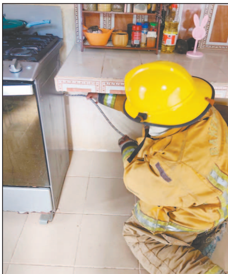
Los tragahumo detectaron una manguera defectuosa. (Justino Xiu)
