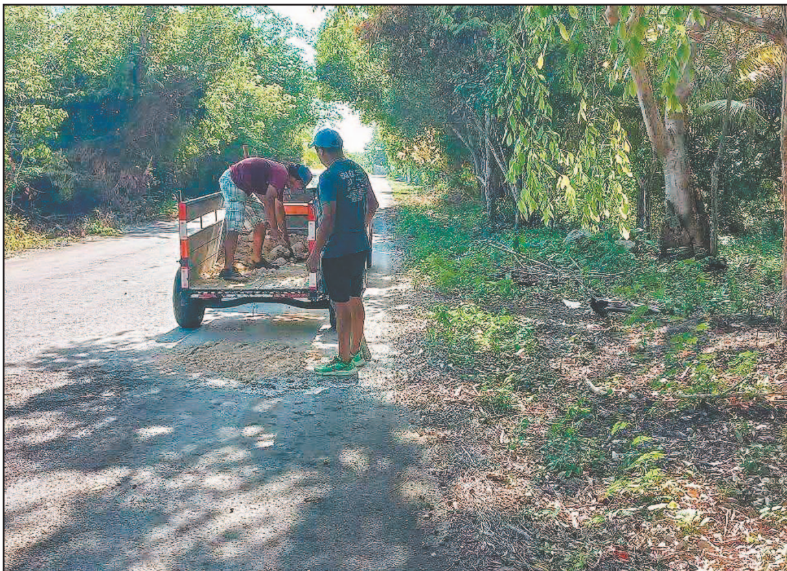
Atletas cubrieron con material los baches de la ruta hacia Laguna Guerrero, debido al desinterés. (F. Olvera)
