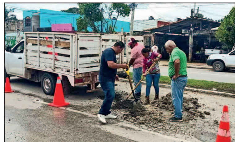
Luego de tapar el hoyo nivelaron el asfalto de la avenida. (POR ESTO!)
