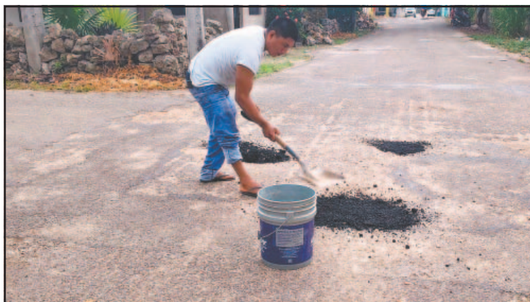
Por falta de asfalto solo pudieron arreglar cuatro calles. (E. Cauch)
