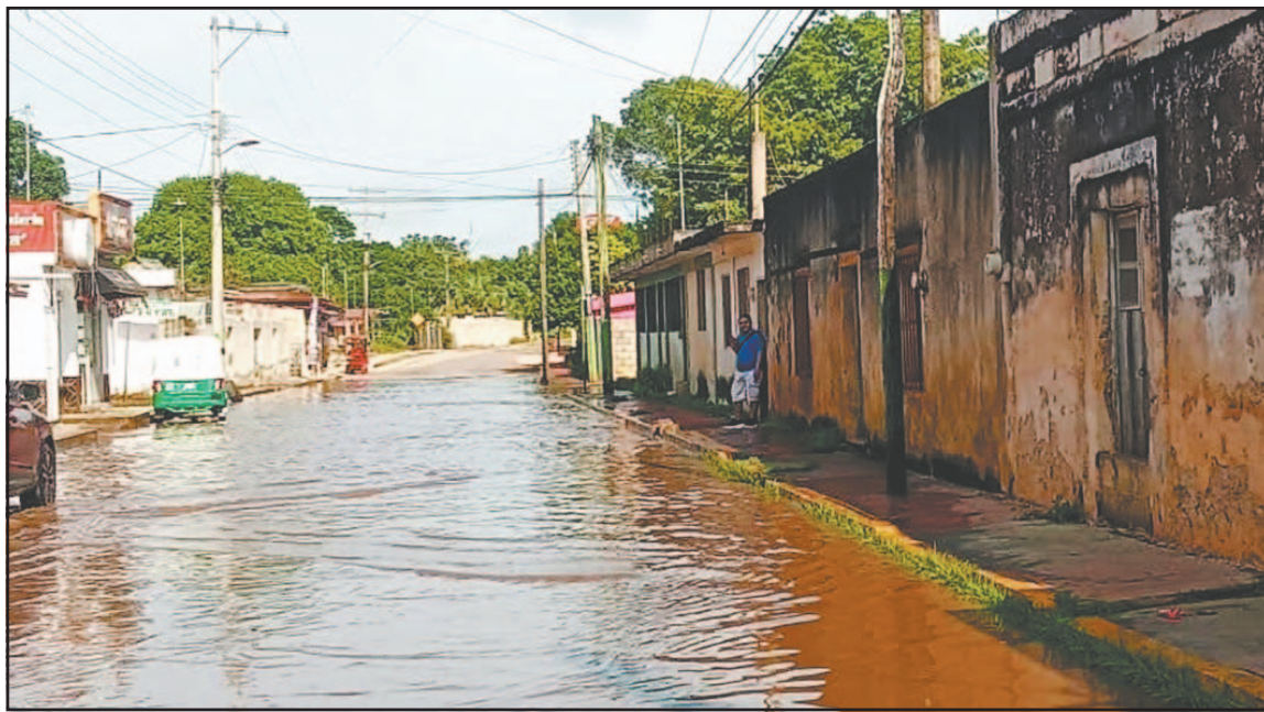
Habitantes señalan que el paso constante de vehículos provoca oleaje que rebasa el embanquetado. (E. Cauch)
